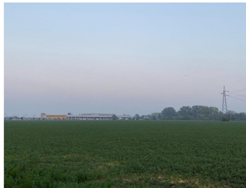
Foto 7 - Vista Fabbricato oggetto di intervento da strada provinciale 12
