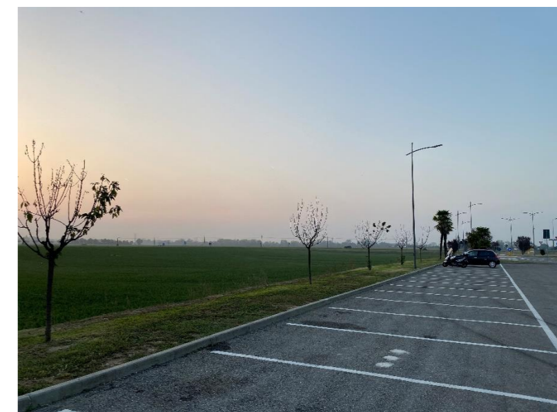
Foto 10 – particolare aree parcheggio
